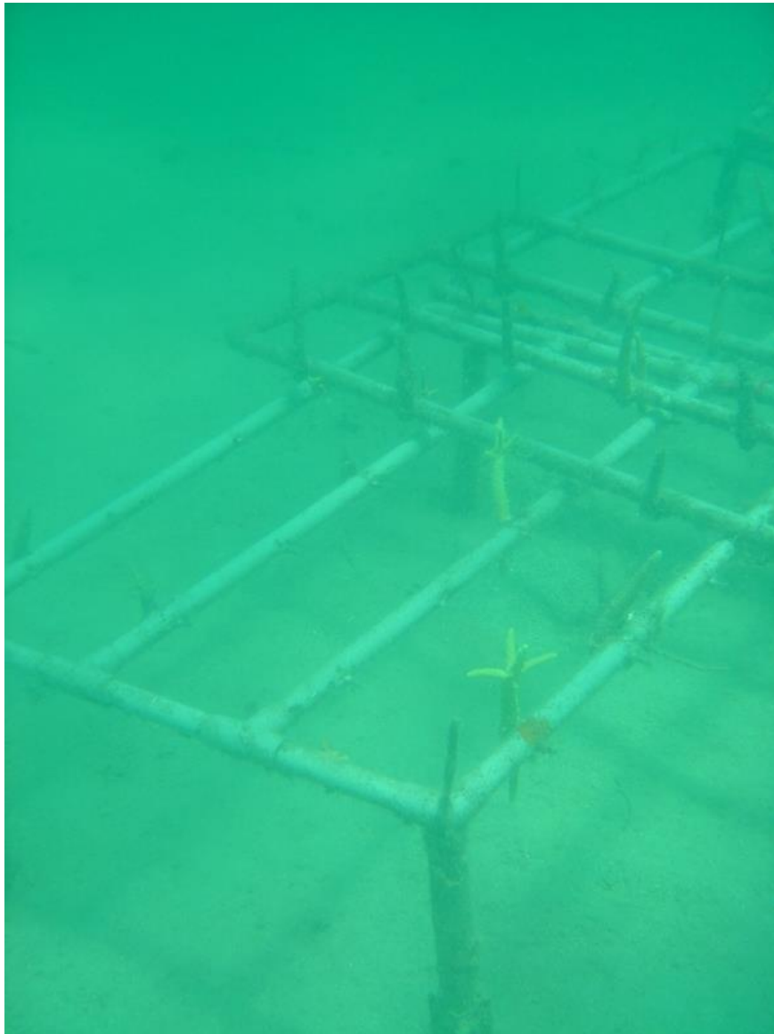
Rajah 3.18 Gambaran keadaan tapak semaian di Air Batang selepas rebut melanda. Diperhatikan bahawa terdapat banyak serpihan karang hilang daripada struktur rangka PVC.
